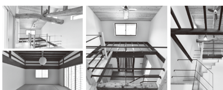
▲古民家リフォームのO邸(H29.4)。耐震補強し、安全で快適な住まいに。立派な梁に吹き抜け天井が開放的。ライフスタイルに合わせて不要な部分は減築した。
