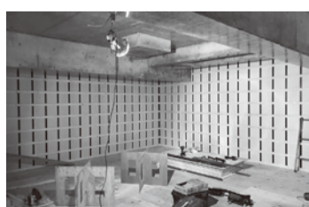
▲▶コンクリート造の地下室
